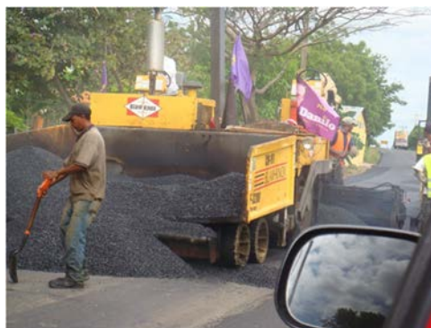
Vehículos y equipos de asfaltados promueven la candidatura del Lic. Danilo Medina del PLD, en la provincia de Montecristi.
