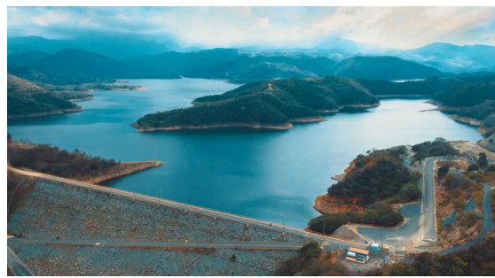
Presa de Monción
