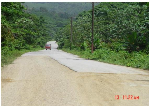
En la mayoría de los caminos vecinales y carreteras, las obras de arte oscilan entre un 40 a un 60% de avance; sin embargo, la capa de rodadura suele estar a nivel de relleno, otras a nivel de imprimación, deteriorándose el trabajo ya realizado por las lluvias y el continuo uso sin terminar la obra.
