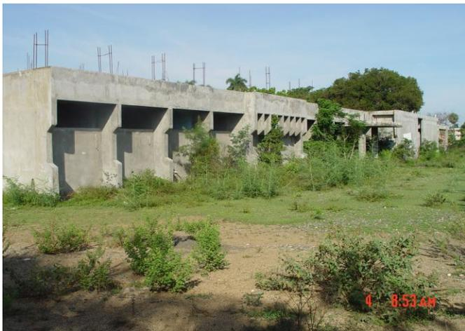
Estas edificaciones se iniciaron a través de la Secretaría de Salud Pública y Asistencia Social (SESPAS), muchas se encuentran a nivel de losa (sin vaciar), otras con la losa vaciada y todos los muros interiores y exteriores pañetados, faltando detalles de piso, puertas, ventanas, instalaciones eléctricas y sanitarias, pintura y equipamiento.
