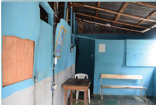
Techo madera/zinc destacamento Santa Luisa, SFM
