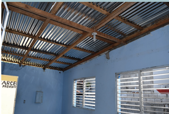
Techo de zinc destacamento San Marcos, Puerto Plata
