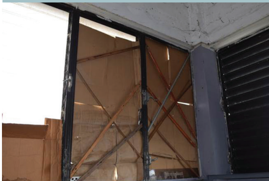
Ventanales Dirección Regional Noreste, SFM
