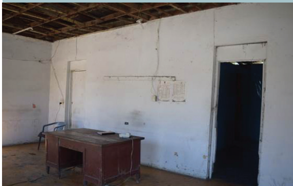
Sede destacamento Villa Palmarito, La Vega
