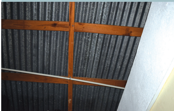
Techo de zinc destacamento Loma del Chivo, DN
