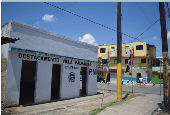
Sede destacamento Villa Palmarito, La Vega
