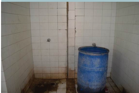
Abastecimiento de agua destacamento Las Cañitas, DN
