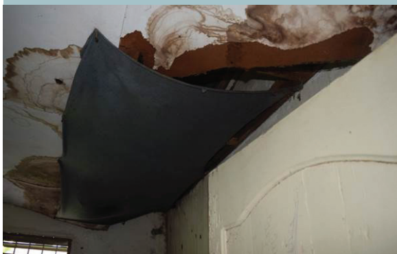
Techo destacamento Vista El Valle, SFM
