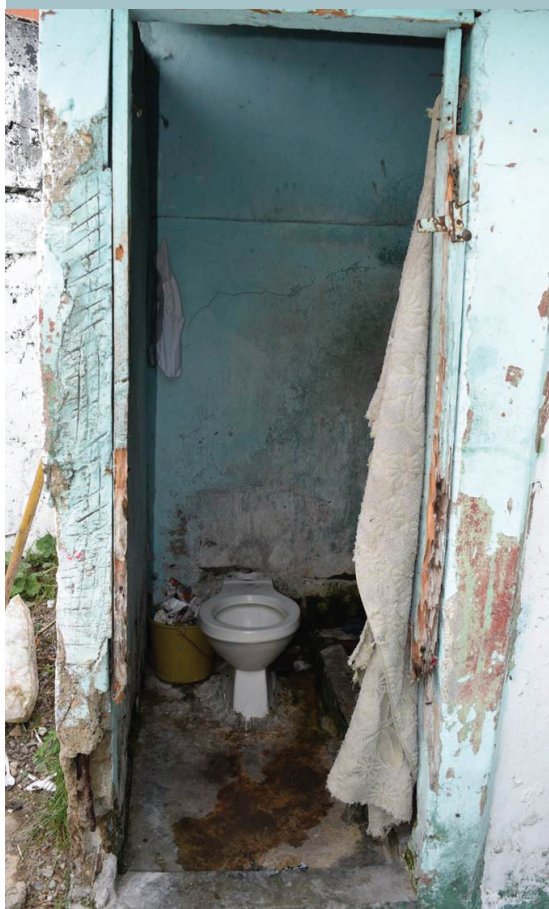
Baño destacamento Las Cañitas 2, D N
